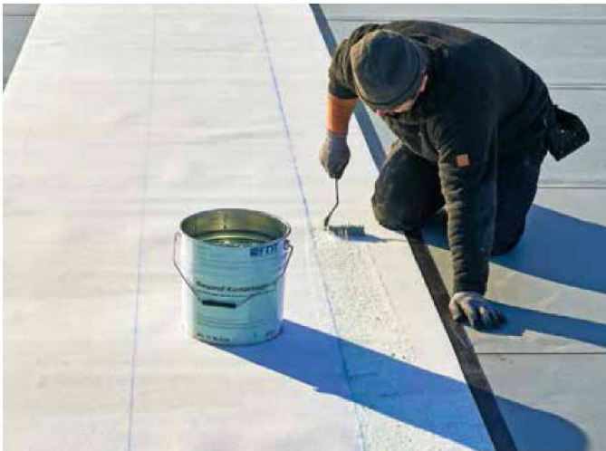
▲ Vorbereitung der Attikaabdichtung mit einem Kontaktkleber
