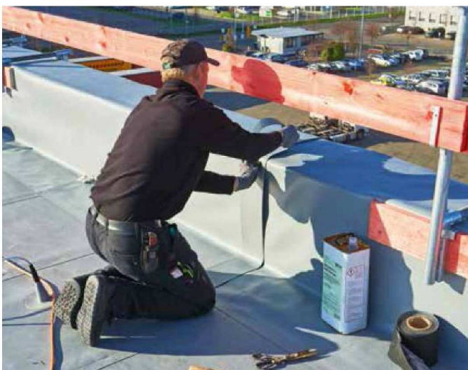
▲ Die Kopfstöße wurden danach mit einem Anschlussstreifen überschweißt
