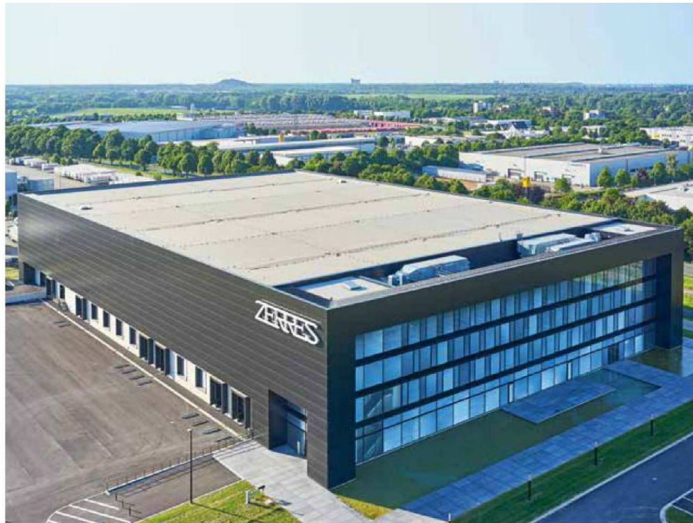
▲ Viel Platz: Die Logistikhalle bietet 31 200 m 2 Nutzfläche und zusätzlich 4800 m 2 für die Verwaltung
