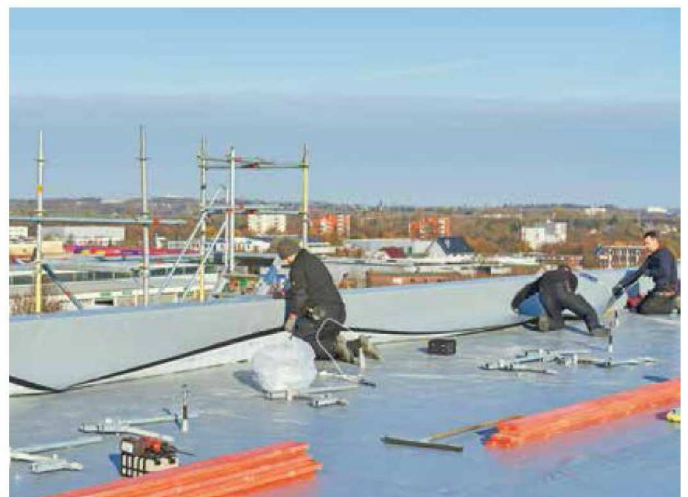
▲ ...und dort fachgerecht durch den Kleber und den Klettstreifen fixiert
