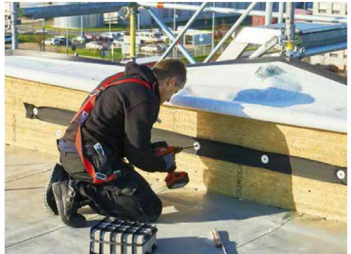
▲ Zusätzlich wurde vor der Dämmschicht ein Klettstreifen angebracht
