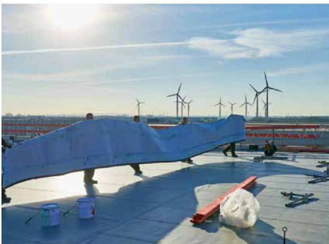
▲ Die vorbereitete Bahn wird von fünf Dachdeckern zur Attika getragen...
